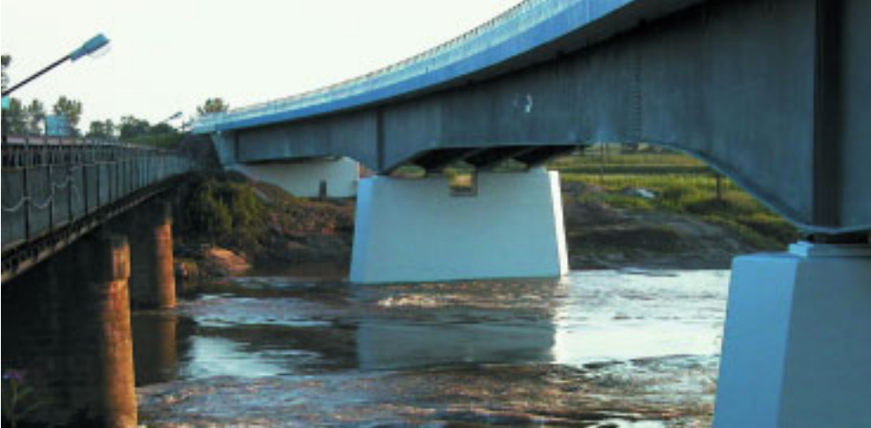
Die 1997 durch das Hochwasser beschädigte polnische Brücke wurde wieder aufgebaut
