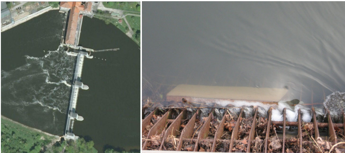
Abb. 4: Die Weser beim Kraftwerk Dörverden (links) und die Rechenanlage (rechts) (Quelle: Anhang 1).
