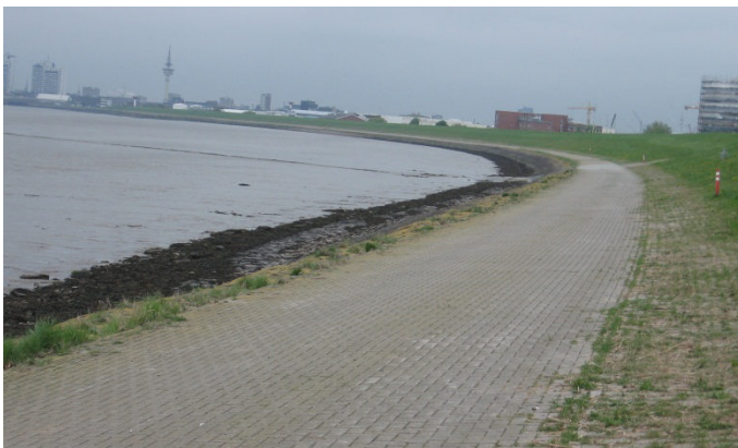
Abb. 8: Sammelstrecke am Deichsicherungsweg in Bremerhaven (Quelle: Anhang 1).
