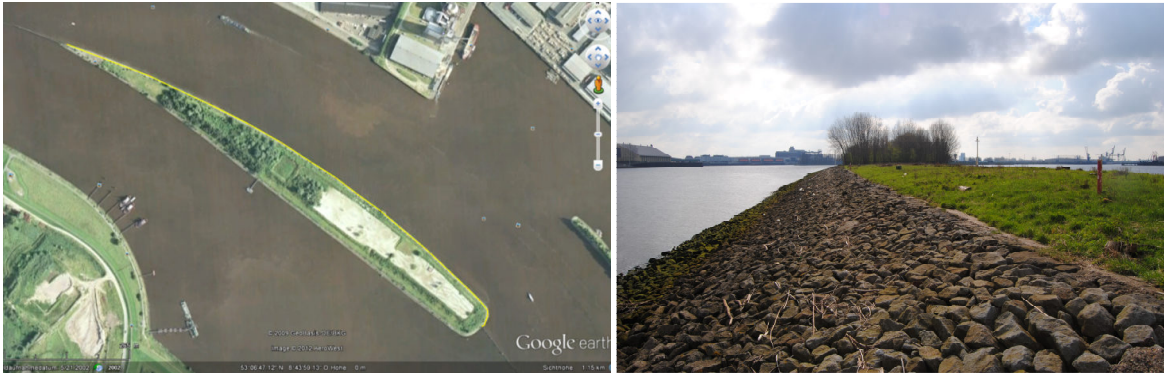
Abb. 5: Die Lankenauer Weserinsel von oben mit der erfassten Strecke (gelb markiert; links) und das mit einer Steinschüttung befestigte Ufer (rechts) (Quelle: Anhang 2).
